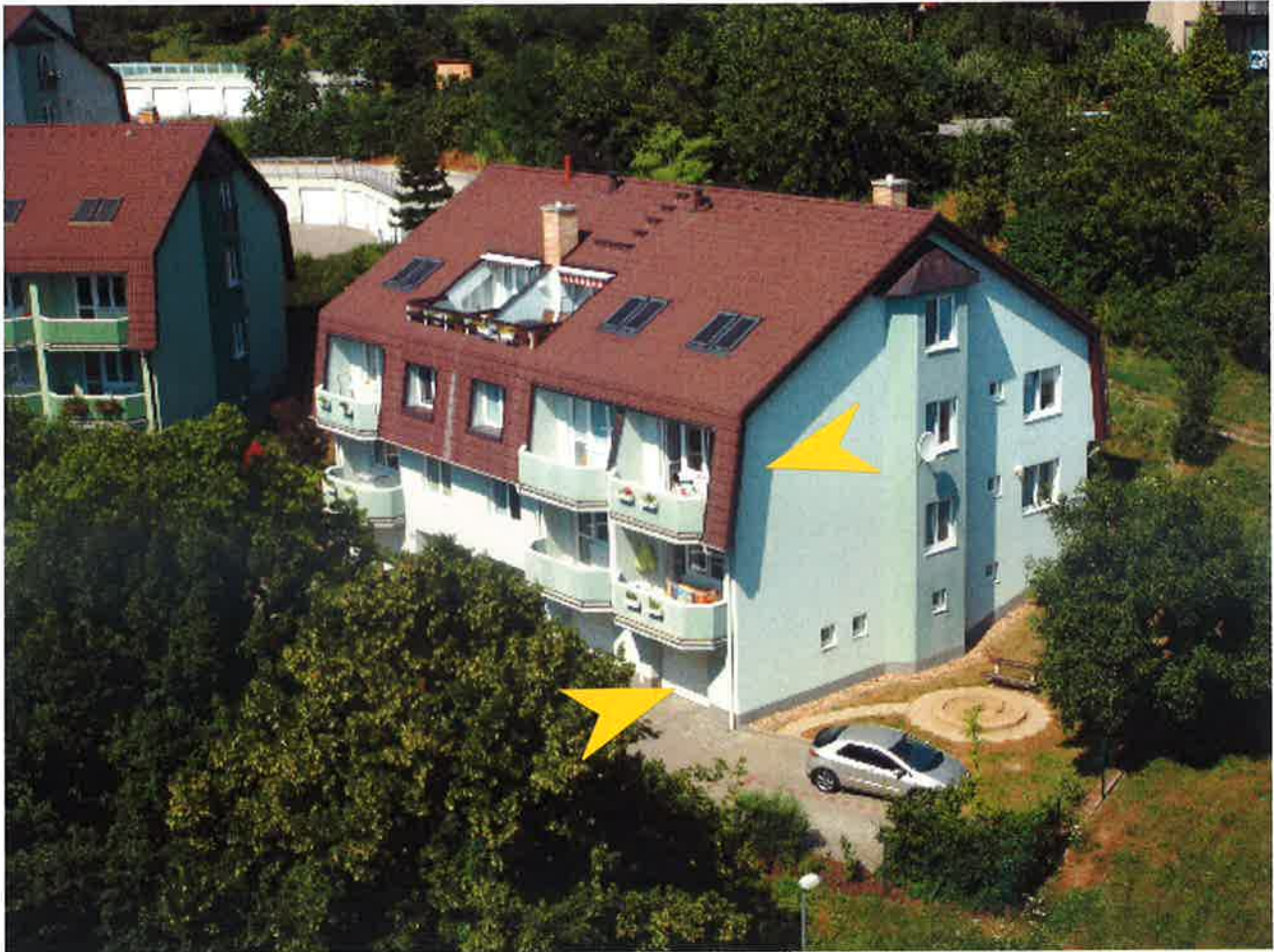
8 bytový zděný dům, Vychodilova 12d, Brno - Žabovřesky, z roku 2005
