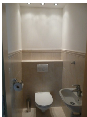
4. WC s umyvátkem
